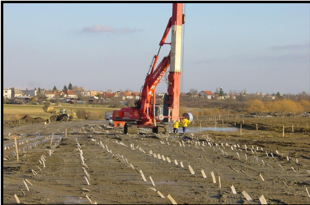
Gambar 2.1 Pelaksanaan pekerjaan pemasangan PVD
